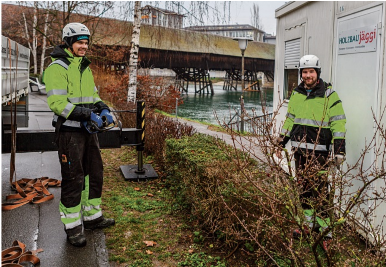
Die Brüder Mischa (l.) und Robin Furrer von der gleichnamigen Gerüstbaufirma beim Aufstellen des mobilen Büros.
